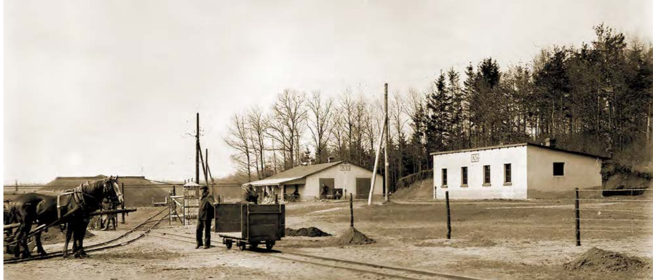
Montáž výroby nitroglycerinu a dynamitu tvořící oddělení A byla dokončována v dubnu 1923. Na fotografii budovy A 33 a A 34.
