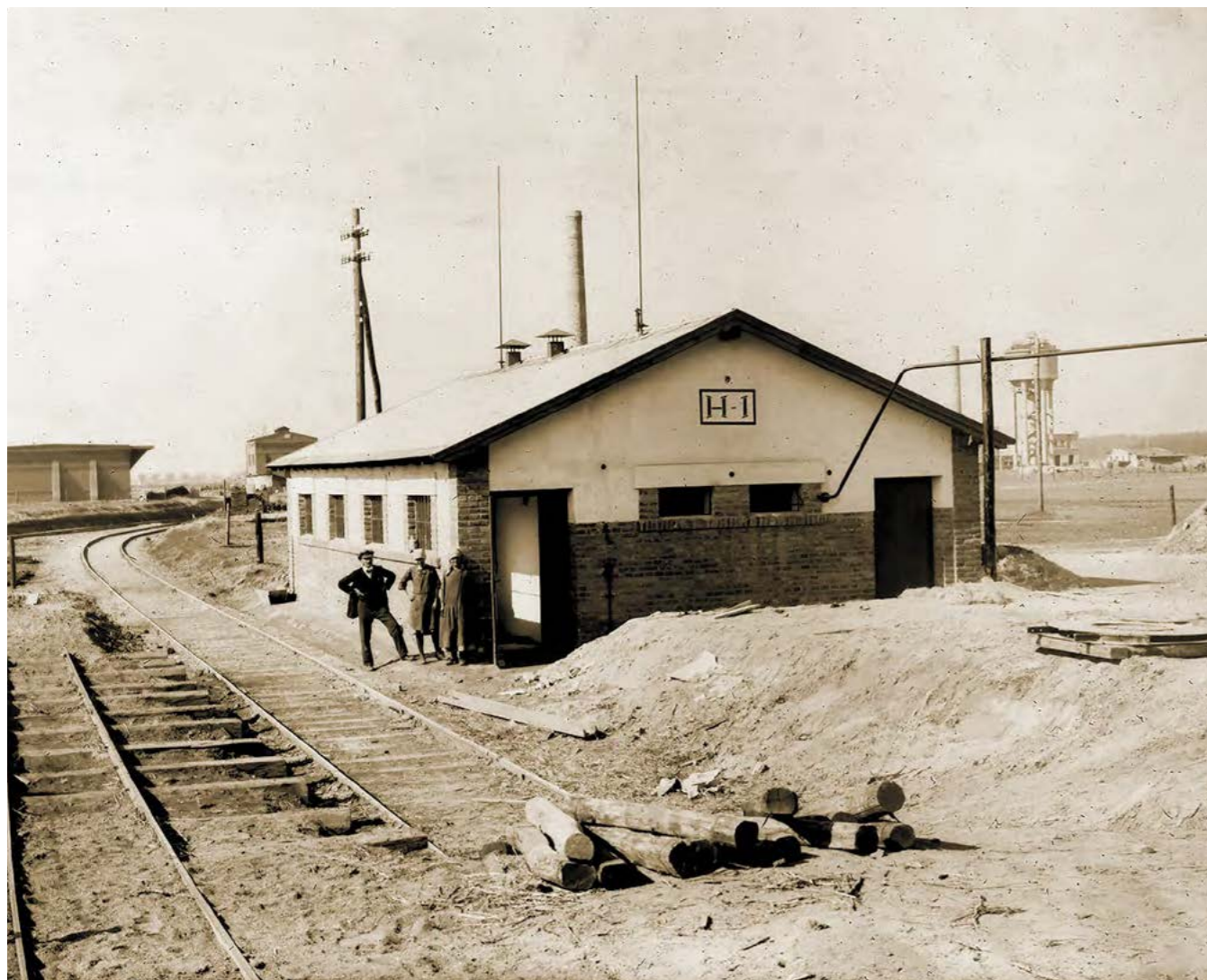
H 1 – budova skladu. Jinak se v budovách označených písmenem H vyráběl tritol.
