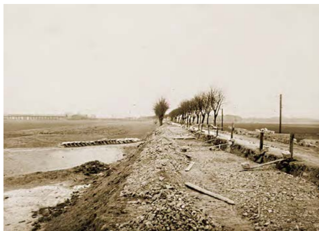
Samotné začátky stavby továrny. Pohled od vlečky k bývalému dvoru.
